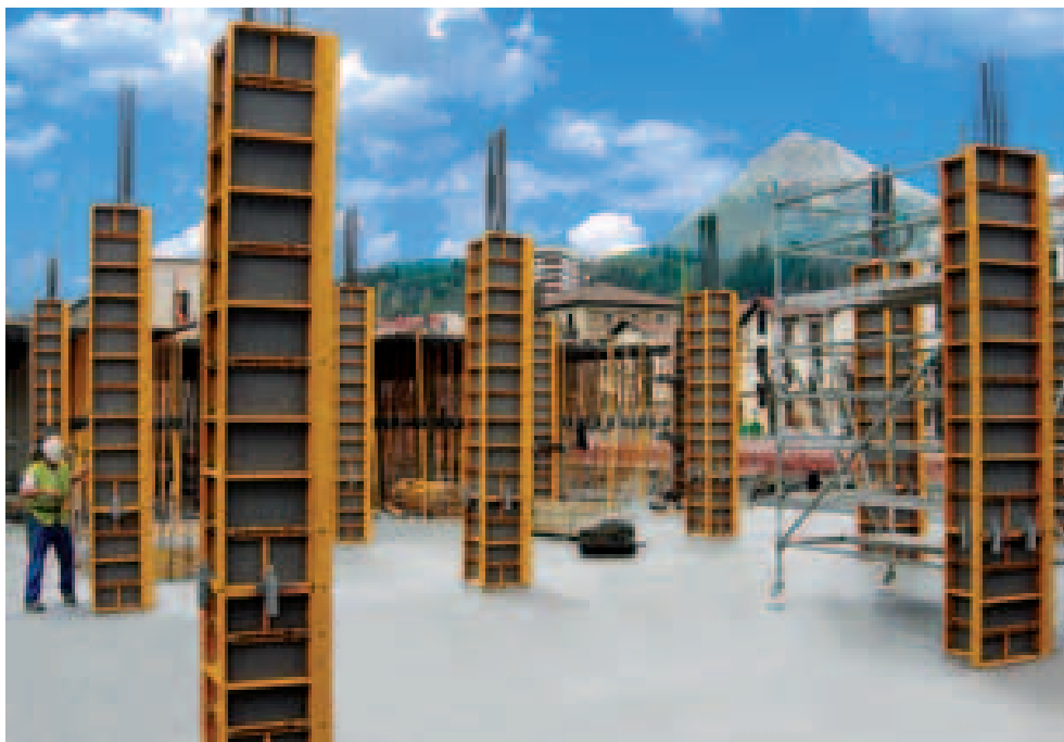
Ejecución de pilares en edificación residencial
